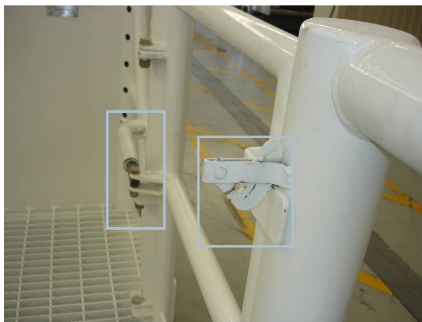
弹簧复位门和自动复位弹簧扣
